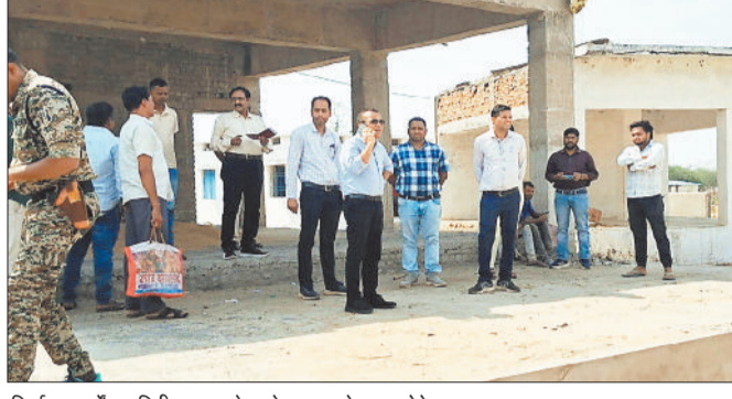
निर्माण कार्य का निरीक्षण करते कलेक्टर जन्मेजय महोबे।
